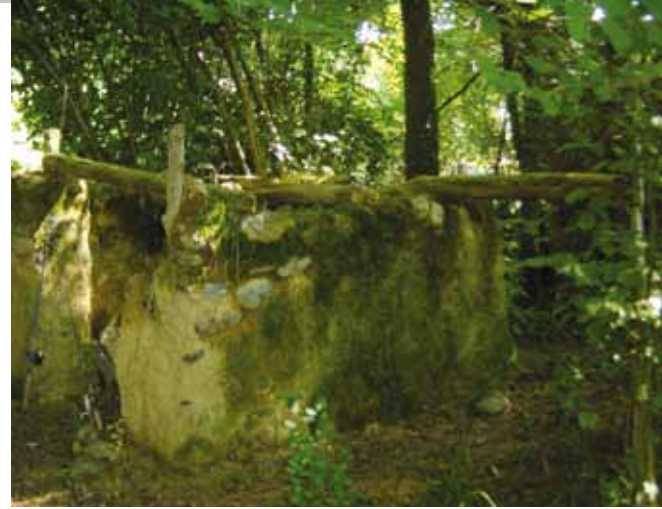
Staudamm, Urhütte, O.Schmidt
